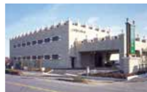
上尾メモリードホール 上尾市東町2-11-5 048-776-0983
